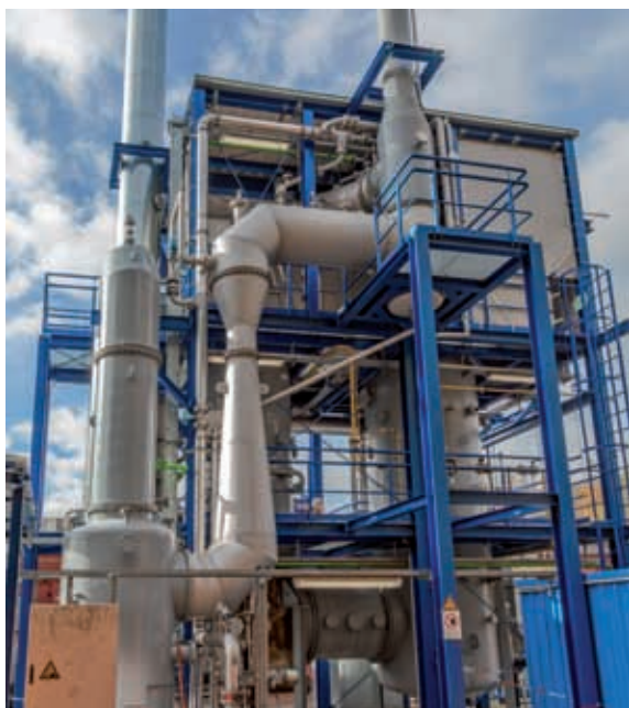
Körtling проводит предварительные работы на площадке
